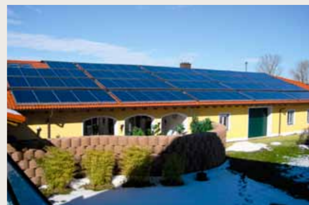
Wellnesscenter des Apartmenthotels Preishof im ostbayerischen Kirchham mit 97 Hybrid-Kollektoren (240 m 2 Kollektorfläche) in Aufdach-Montage. Solarertrag pro Jahr: 67.700 kWh für Warmwasserbereitung und Heizung, zzgl. 13.000 kWh Strom.
