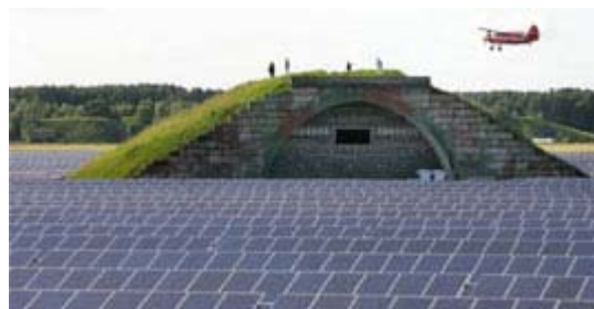
Solar-Kraftwerk FinowTower. Ehemalige Flugzeugbunker wurden zu "Fledermaus-Hotels" umgebaut
