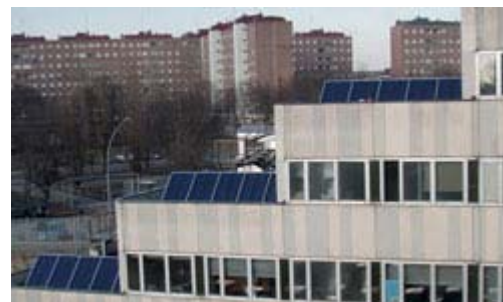
Solaranlage auf dem Dach des San Carlo Borromeo-Krankenhauses in Mailand
